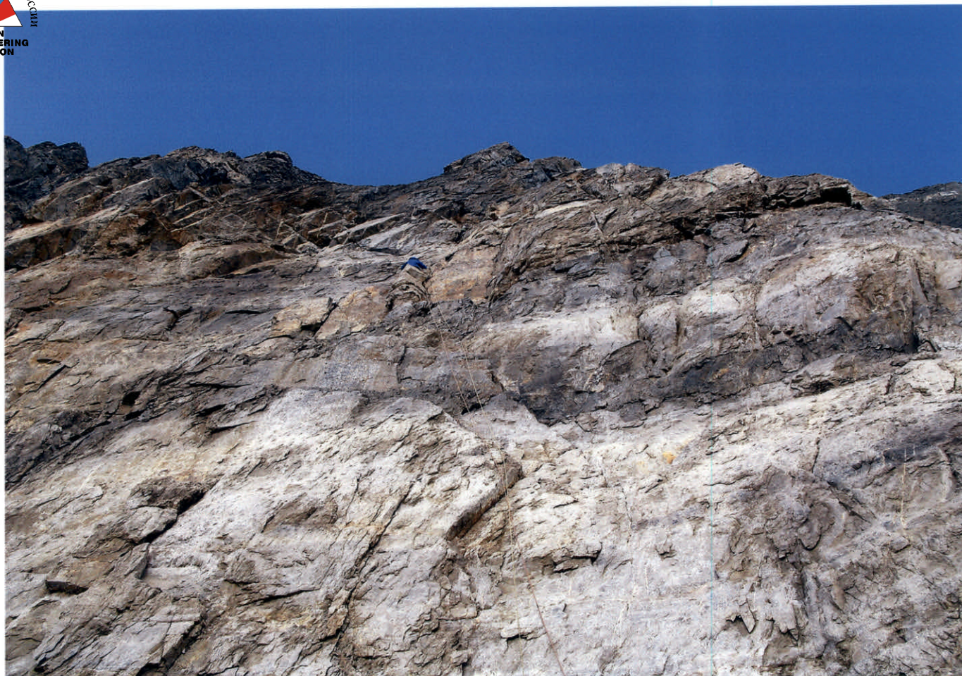
Фото 13. Работа связки на участке R 19 - 20
