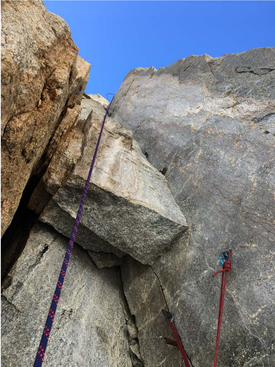
Фото 3. Вид снизу на участок R2-R3. Карнизы.
