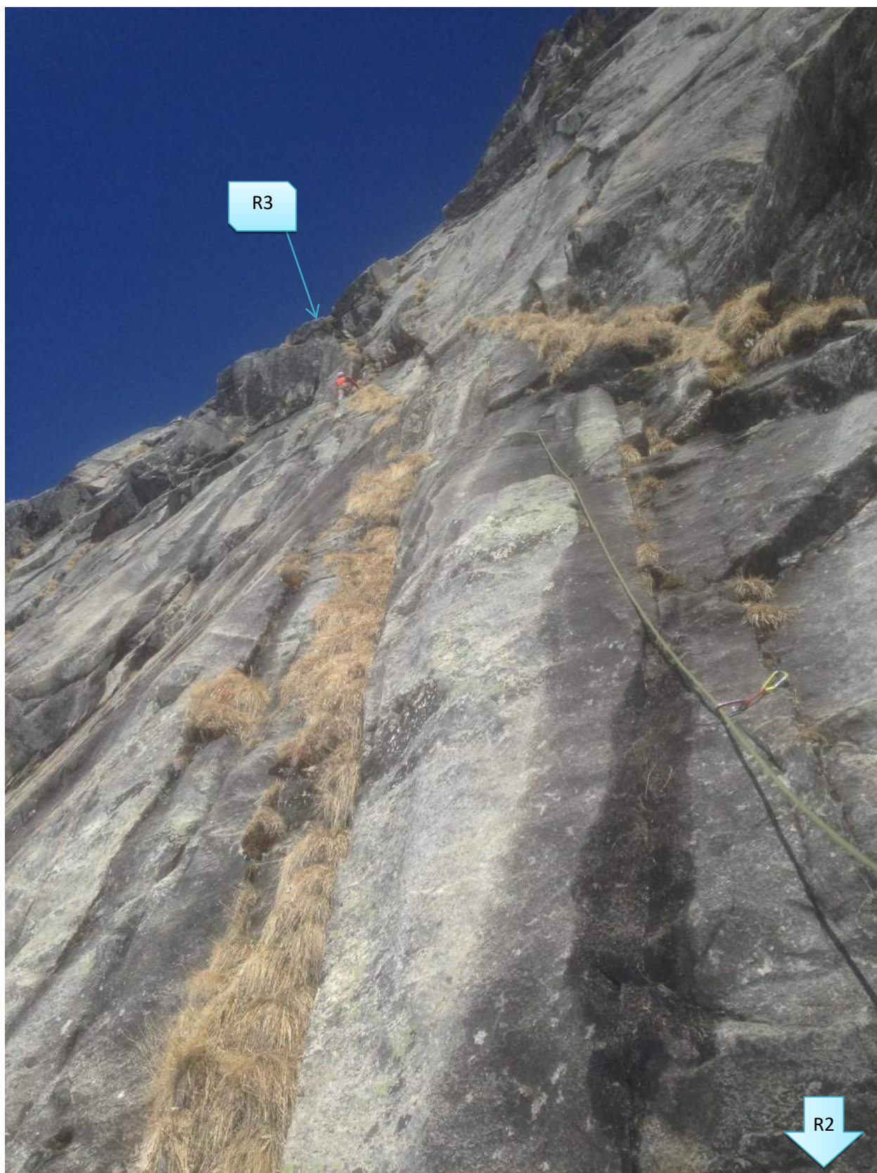
Фото 6. Середина участка 2-3 выход на карнизный пояс
