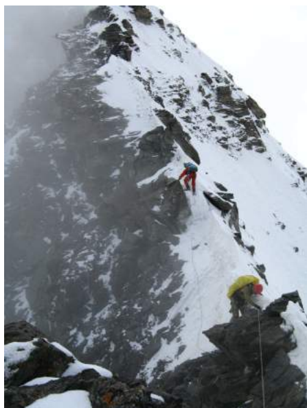
Фото 17. Разрушенный скальный гребень на участке 5330–5418
