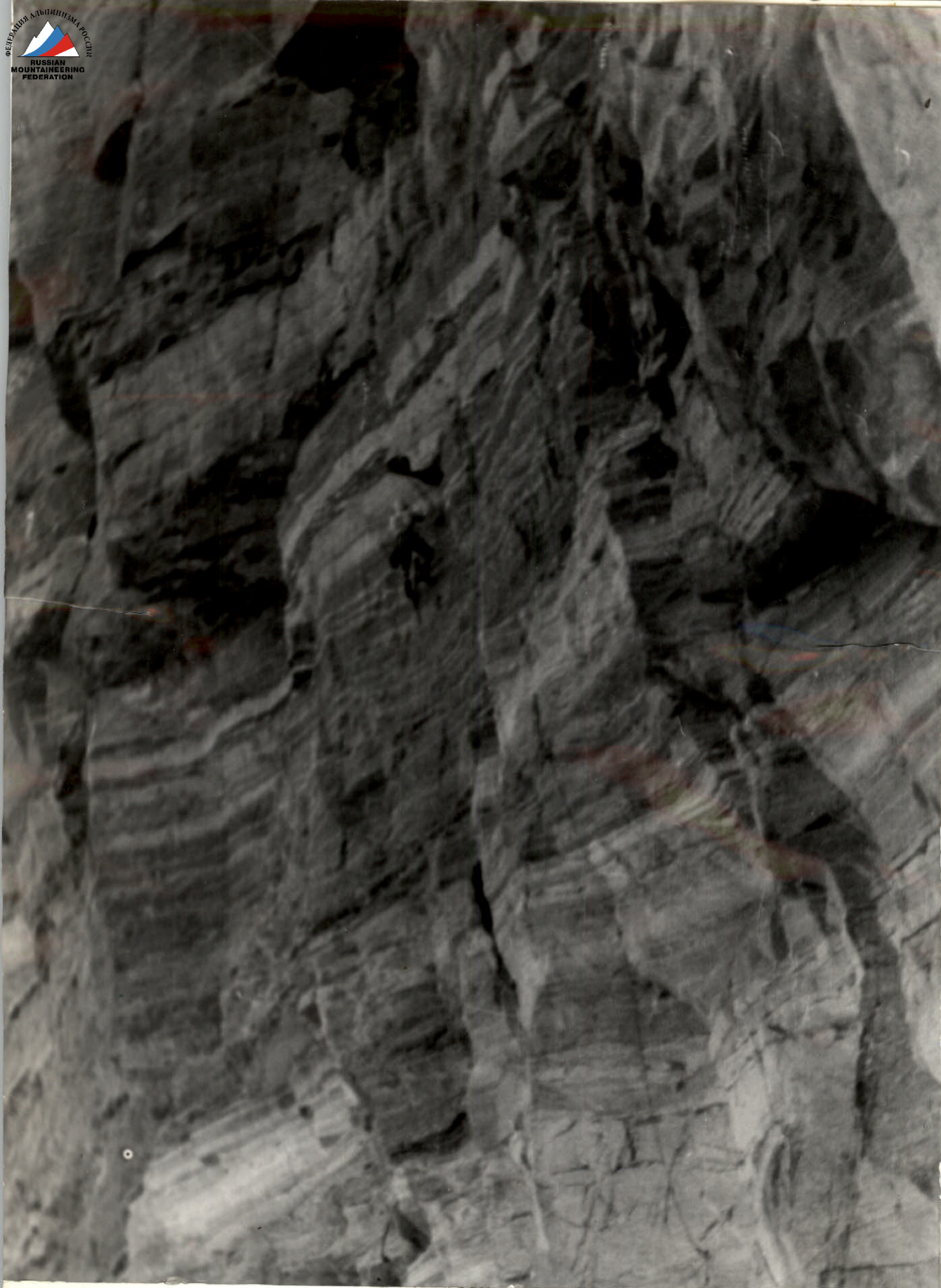
Фото 12. Нависающая стена. Участки 23-28.
