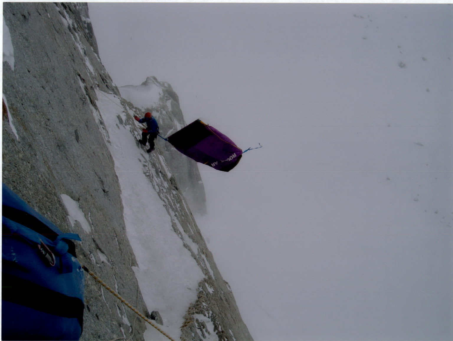
Участок 3-4, Транспортировка платформы
