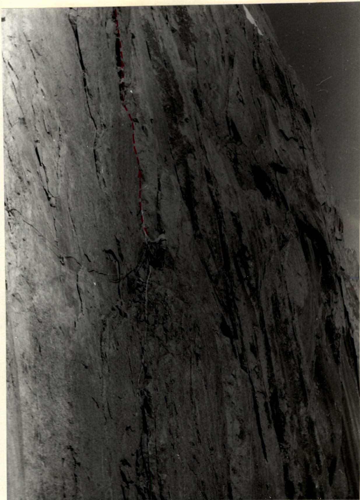
Фото - 10. Стена на участках 33-36.
