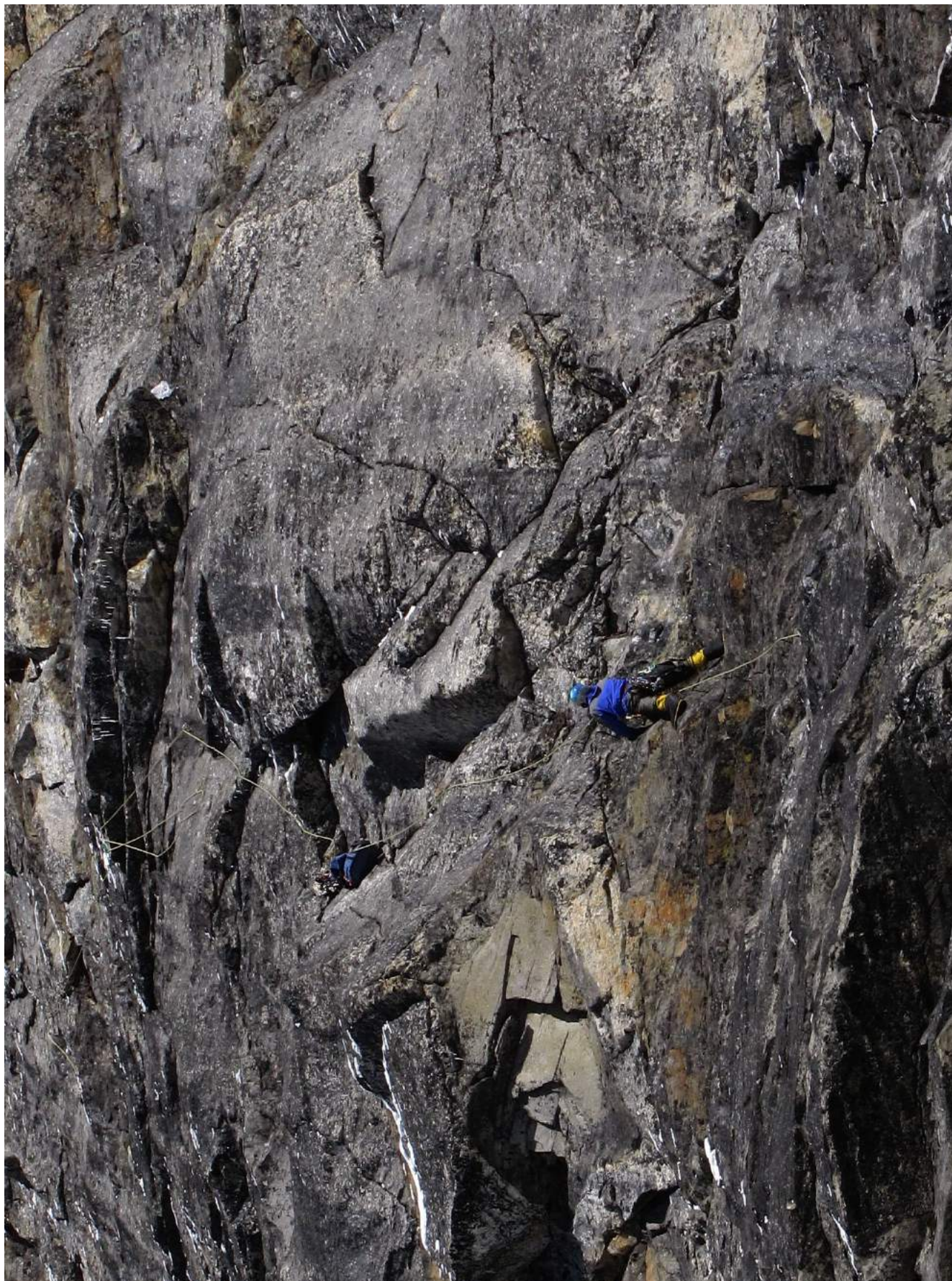
Фото 18. Середина участка R12, карнизы
