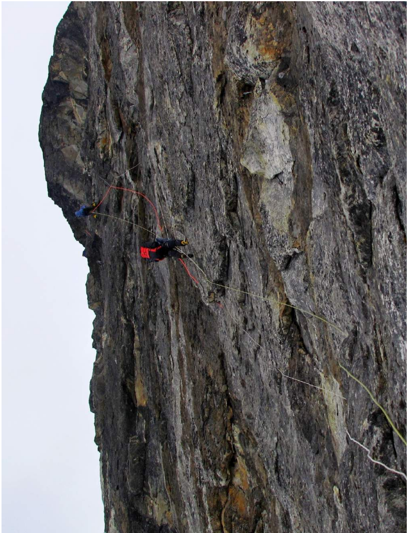
Фото 21. Участок R 13 с большим карнизом справа..
