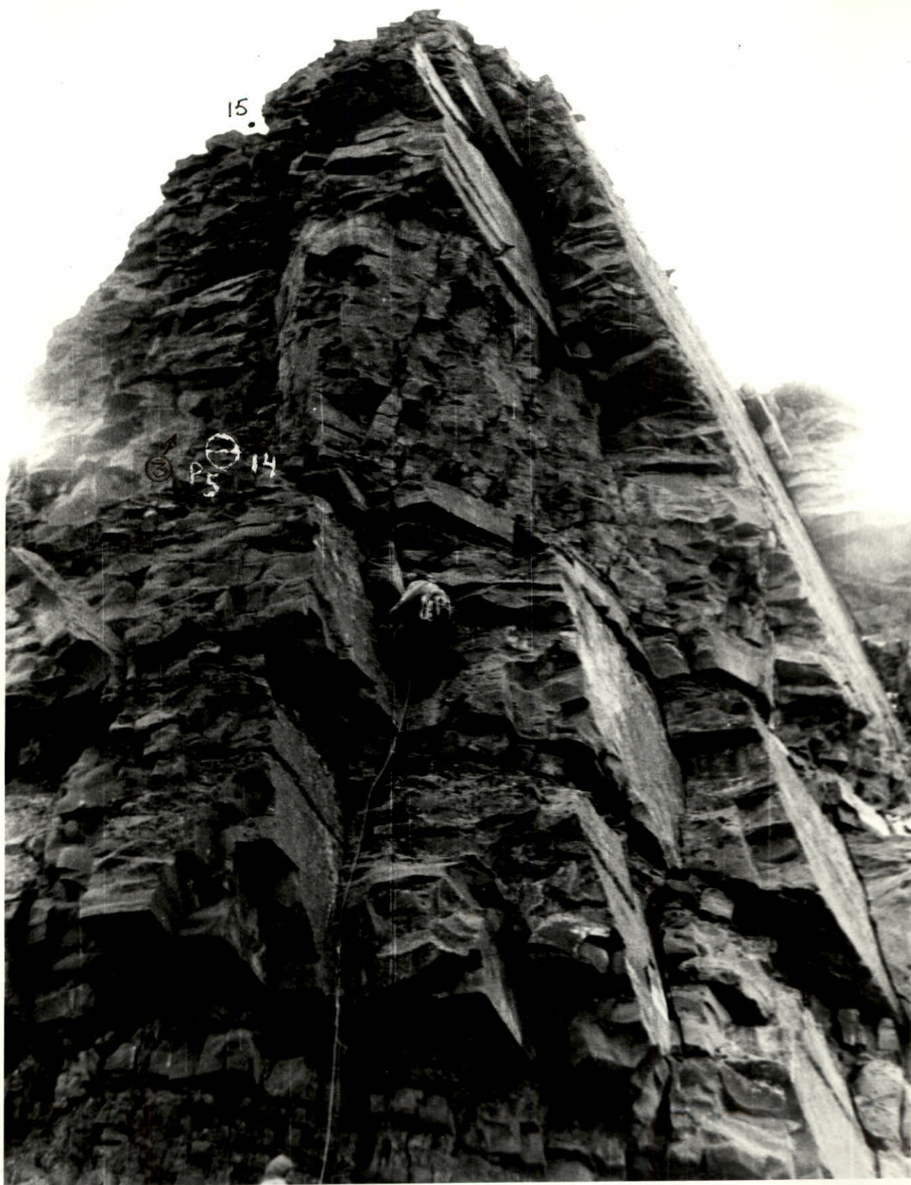
Фото 2. Участки 12-15. Второй пояс скал. На участках 12-13 первым работает Дорро К. Фото с точки 11. Смена 8М. 1.07.95г.
