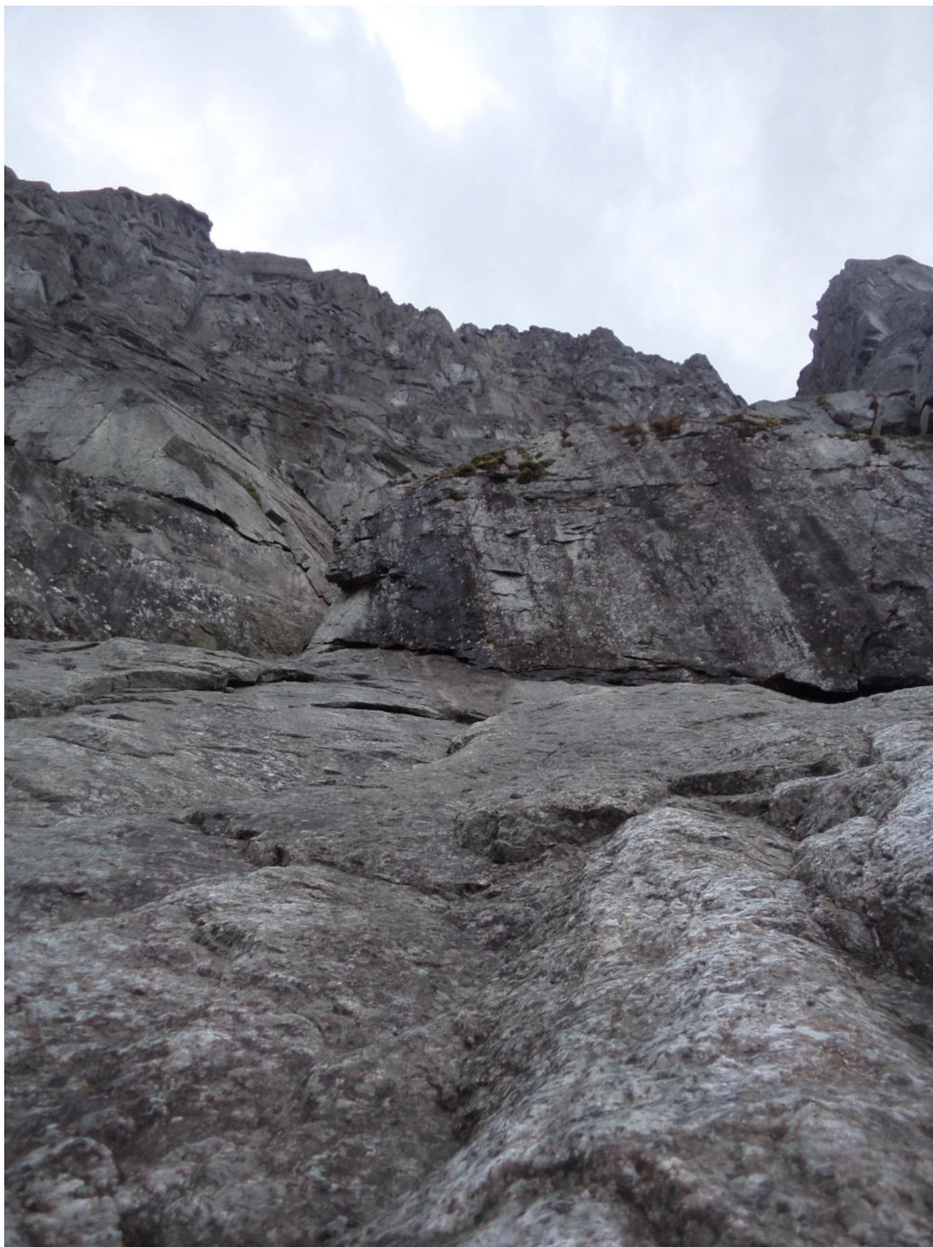
R2 - R3, верхняя часть. Станция R3 слева от черного подтека у входа в камин.
