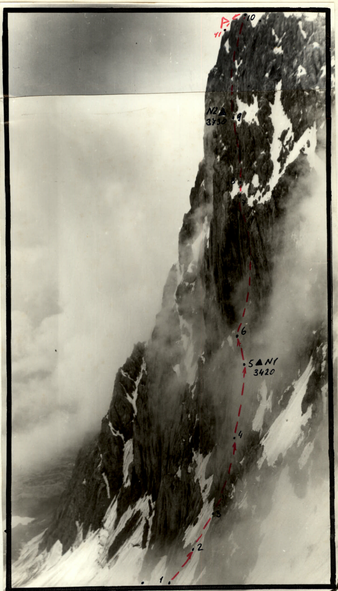
Фотогр. 2 Профиль стены справа снята с пер. Гауки (С.) 22 июля 1983 г. Объектив Helios 46-2"
