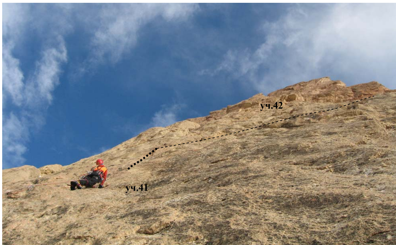
Фото 5. Начало стенной части второго бастиона. Колтунов Олег на участке 41. Участок 42 плохо видно за ребром, которое наложено на стену. Фото с R18.
