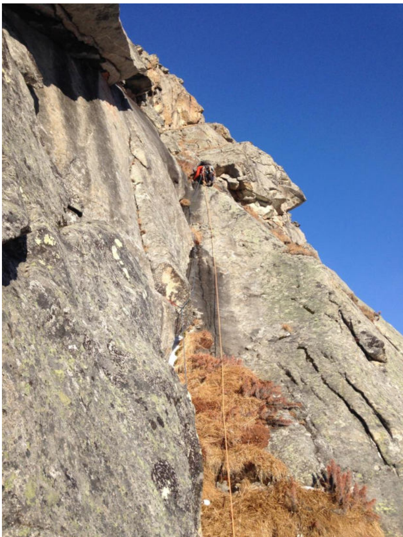
Фото 9. На участке R2-R3 работает М. Ахметов
