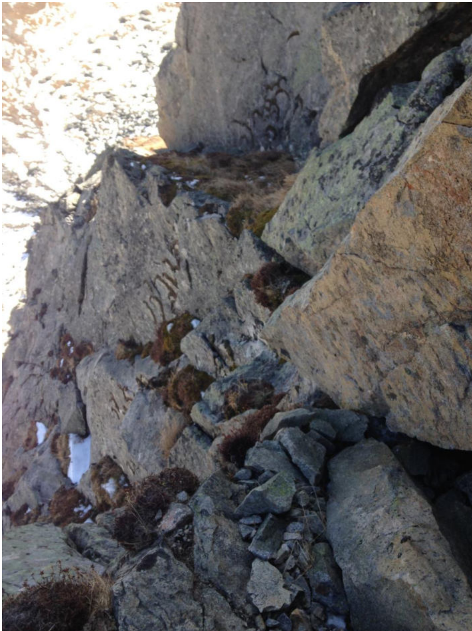
Фото 12. Провал в травянистой полке на участке R4-R5
