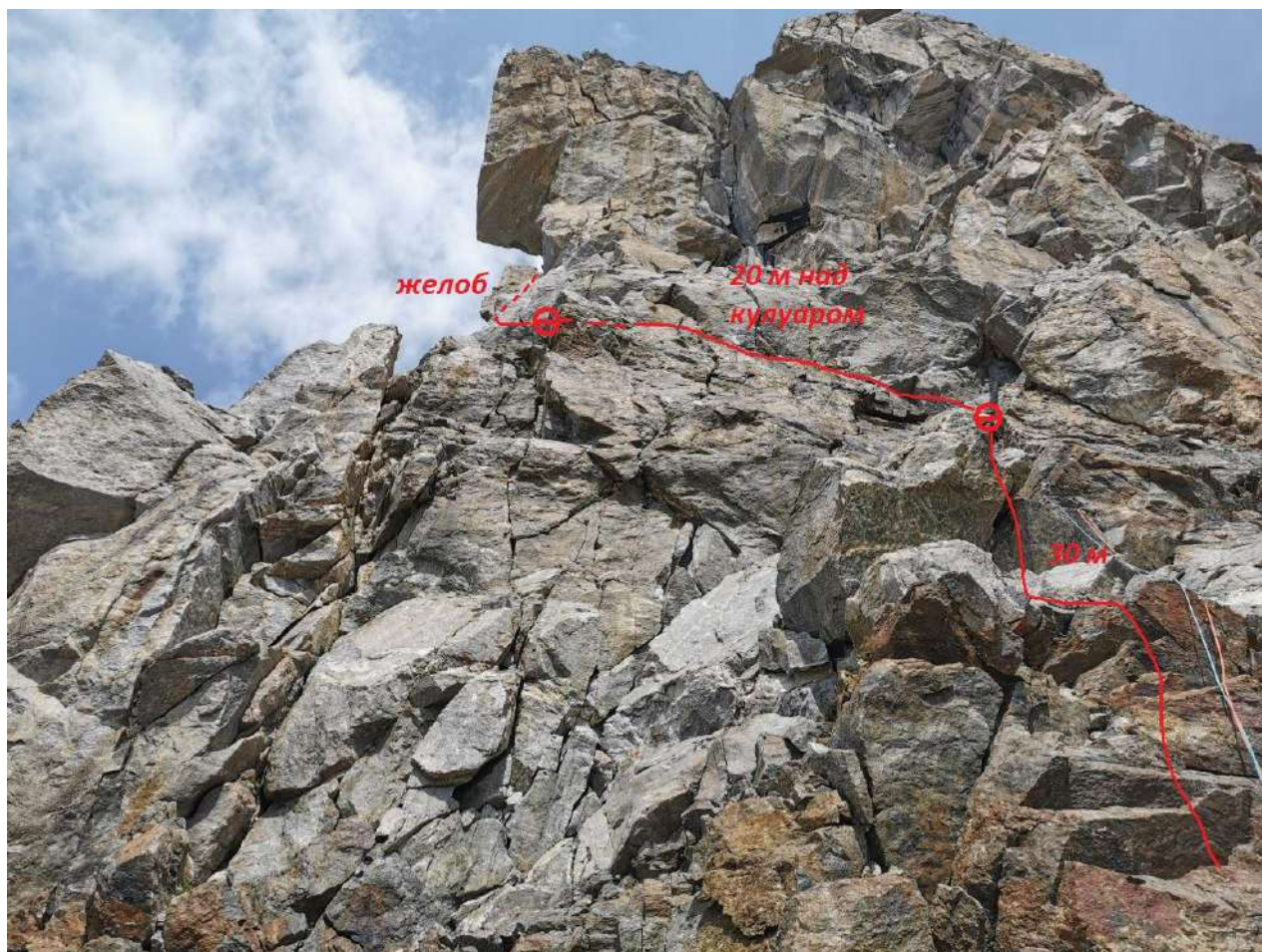
Рис. 7.1 Вид на участок R3-R4 с площадки у к.т.
