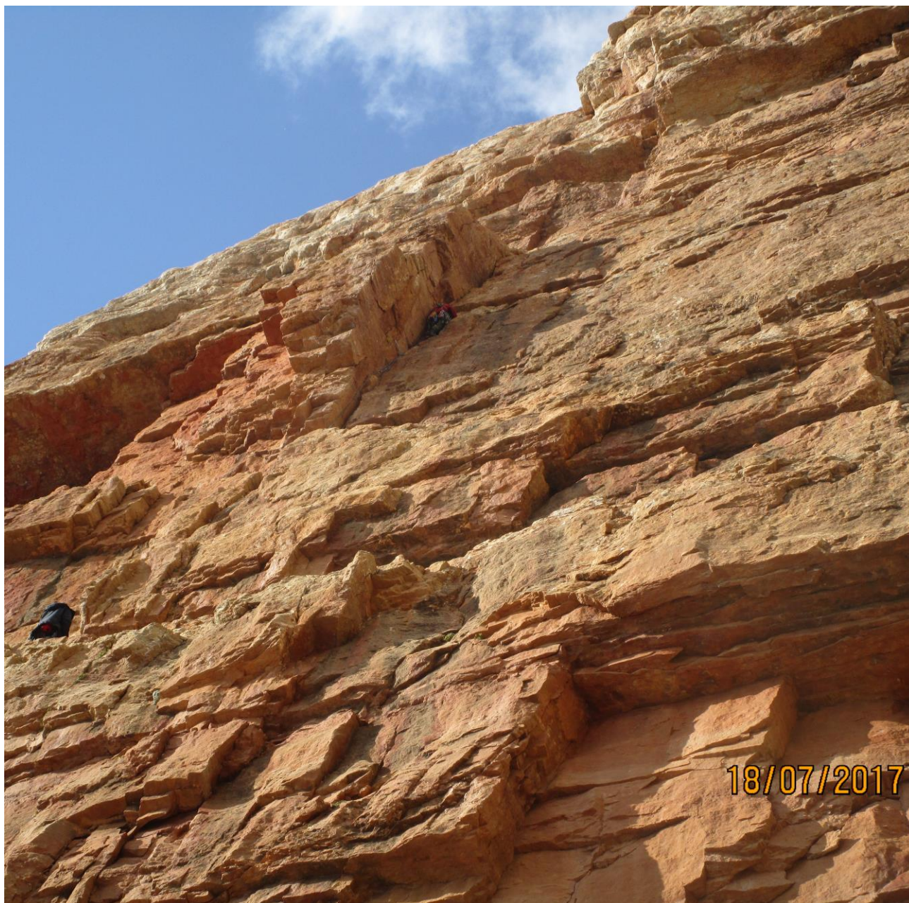
Фотография № 18. Прохождение участка R21-R22.
