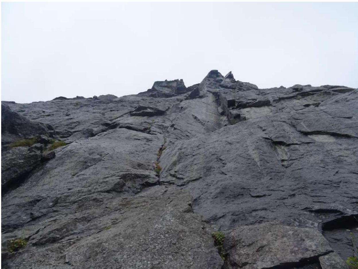
Фото 5. Общий вид на 1-й пояс, участки R3 – R5.
